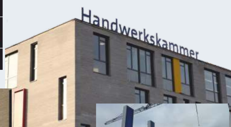
Freistehende Dachwerbung am ZEG Koblenz extern angestrahlt, zwei-farbig lackierte große Reliefbuchstabe, inkl. Stahlunterkonstruktion
